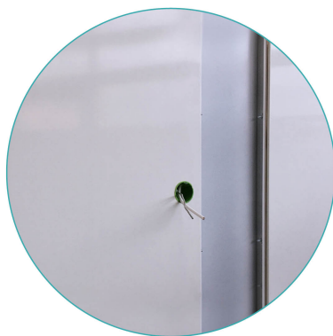
Odkrytý instalační sloupek a elektroinstalace
