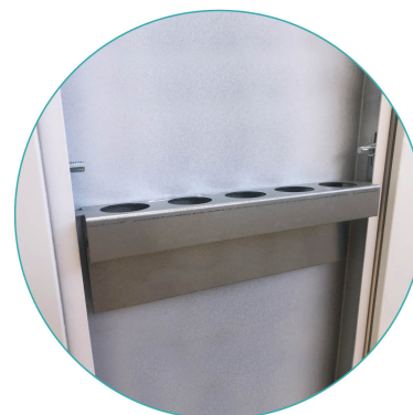
Odkrytý instalační sloupek
