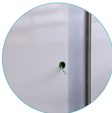
Odkrytý instalační sloupek a elektroinstalace
