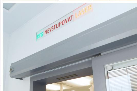
Светильник НЕ ВХОДИТЬ служит для предупреждения лиц, передвигающихся в чистом помещении, о возможной опасности, связанной с входом в определенные рабочие зоны, такие как, например, действие Рентгеновского излучения, или мощного лазера.
