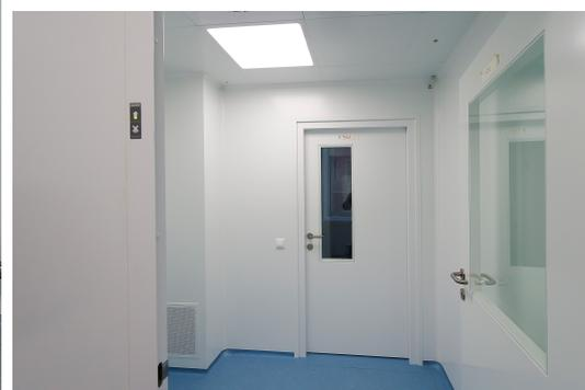
Противопожарная перегородка с пределом огнестойкости EI60 была подвержена испытаниям как гипсокартонная перегородка с двойной облицовкой общей толщиной 138мм. (без облицовки металлическими кассетами), с возможностью установки противопожарного остекления. После наклеивания облицовочных металлических кассет перегородка удовлетворяет всем требованиям использования в чистых помещениях. Металлические кассеты можно приклеить с одной стороны (только со стороны чистого помещения) или с двух сторон.
