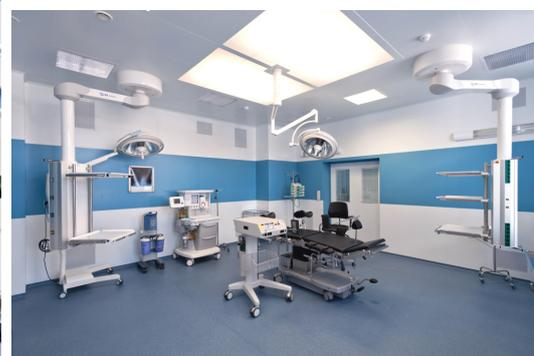
Фильтровальный выпуск служит для обеспечения равномерного потока воздуха регламентированной чистоты в септических и асептических операционных залах.
