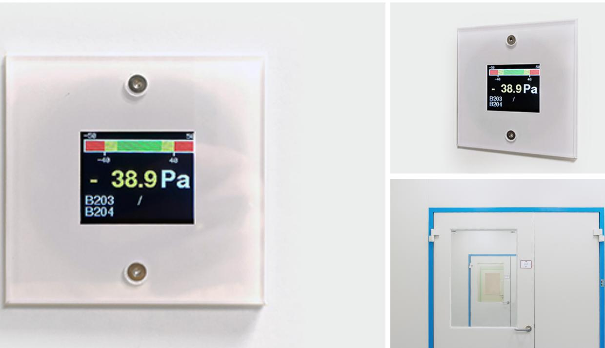
Prístroj slúži na zobrazenie hodnôt z čidla alebo z riadiaceho systému. K ľahšej orientácii o správnych požadovaných hodnotách sa požadovaný rozsah zobrazuje ako graficky, tak aj v číselnej hodnote. Zobrazovač je navrhnutý univerzálne tak aby mohol zobrazovať jednotky tlaku, vlhkosti alebo teploty. K zobrazovaču je možné pripojiť čidlo 0-10V alebo 4-20mA. na displeji ide nastaviť ako čísla miestnosti medzi ktorými je hodnota porovnávaná tak aj číslo meracieho bodu.
