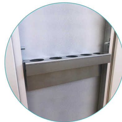
Odkrytý inštalačný stĺpik
